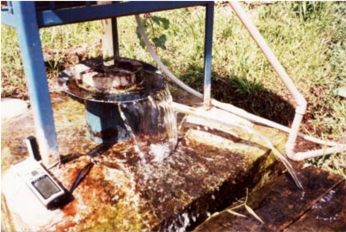
Figura 50 - Poço jorrante localizado na Linha Bela Vista – São Lourenço d'Oeste, com vazão livre de cerca de 4 \text{ m}^3/\text{h} (poço n°1875).
