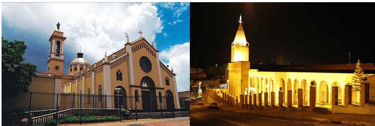
Figura 36 Esquerda – Igreja de Nossa Senhora da Abadia, Direita – Igreja de Nossa Senhora da Medalha Milagrosa
