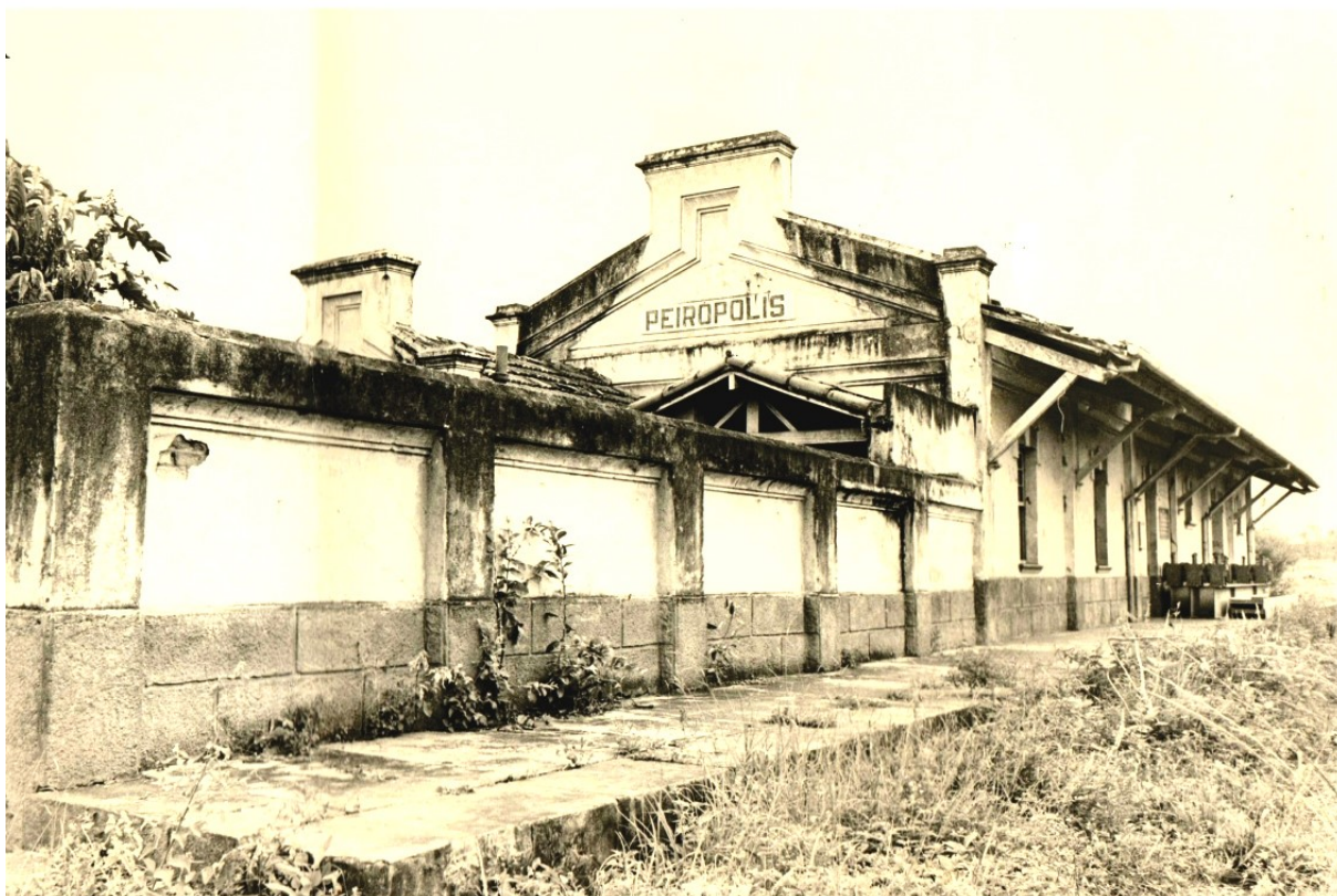
Figura 47 Estação Ferroviária de Peirópolis na década de 1980.
