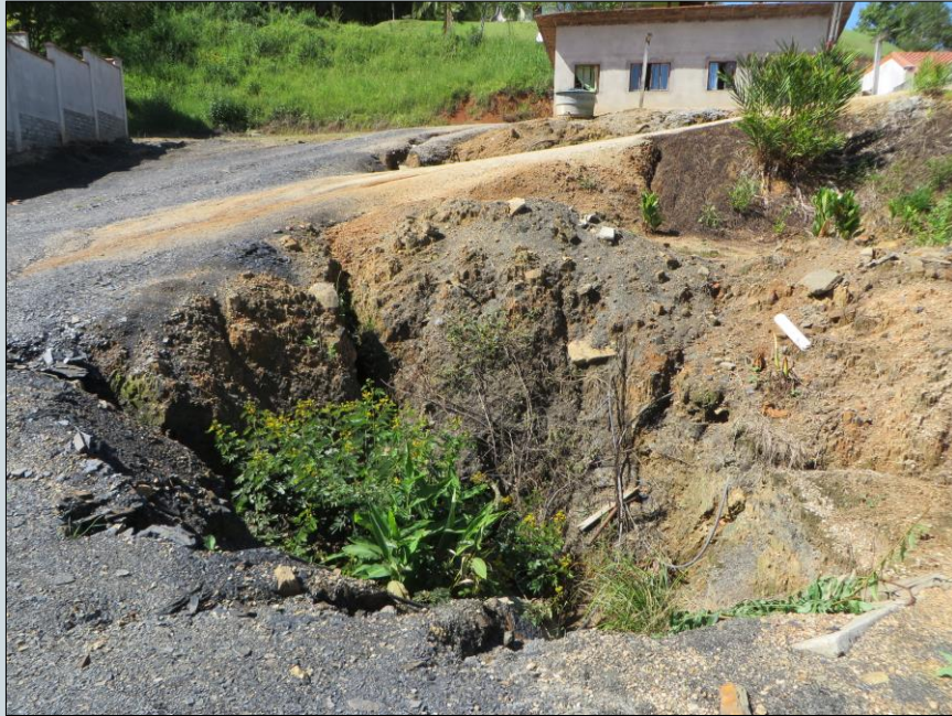
Via sem pavimentação, Alfredo Wagner– SC. Créditos: Débora Lamberty, CPRM/SBG
