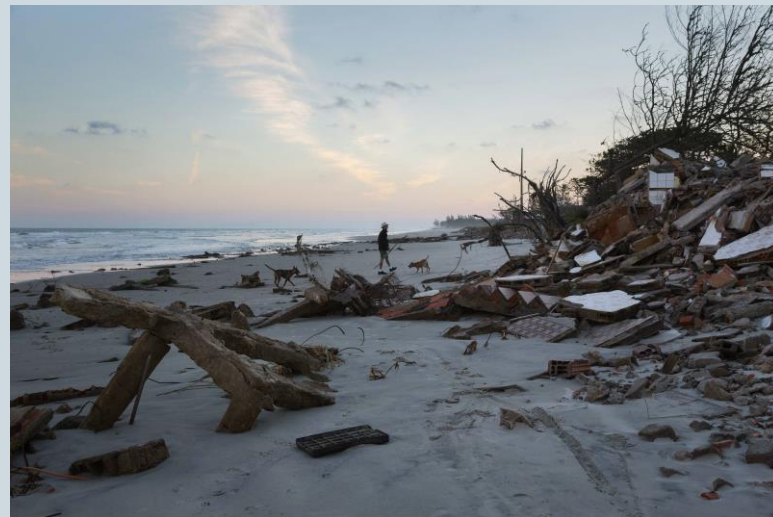
Entulhos de construções que foram destruídas pelo mar e parcialmente cobertos pela areia em Ilha Comprida, no litoral sul de São Paulo. Fotografia: Lalo de Almeida/Folhapress. Fonte: < https://arte.folha.uol.com.br/ciencia/2018/crise-do-clima/litoral-paulista/no-litoral-de-sp-erosao-come-praias-e-ate-casas-inteiras-obras-buscam-protecao-contra-ressacas-mais-frequentes/ >. Acesso em 07/08/2020.
