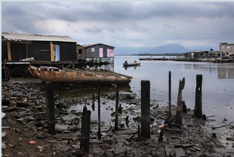
Favela do Mangue Seco, na zona noroeste de Santos. Fonte: < https://arte.folha.uol.com.br/ciencia/2018/crise-do-clima/litoral-paulista/no-litoral-de-sp-erosao-come-praias-e-ate-casas-inteiras-obras-buscam-protecao-contra-ressacas-mais-frequentes/ >. Acesso em 07/08/2020.
