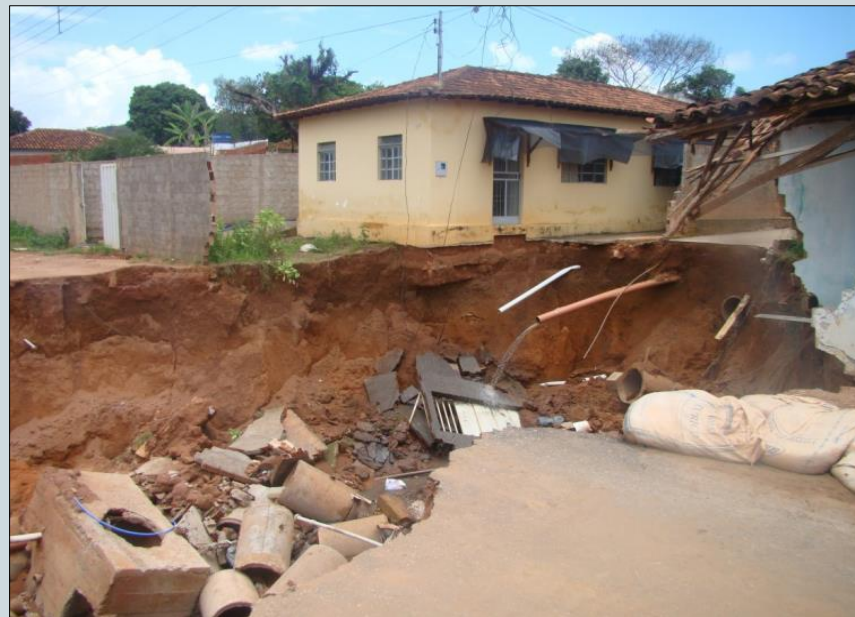
Erosão causada por sobrecarga do sistema de drenagem pluvial. Capelinha – MG. Créditos: Júlio Lana, CPRM/SBG
