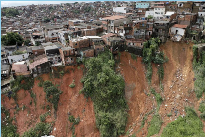
Deslizamentos generalizados Local: Salvador - BA Créditos: Portal No Ar
