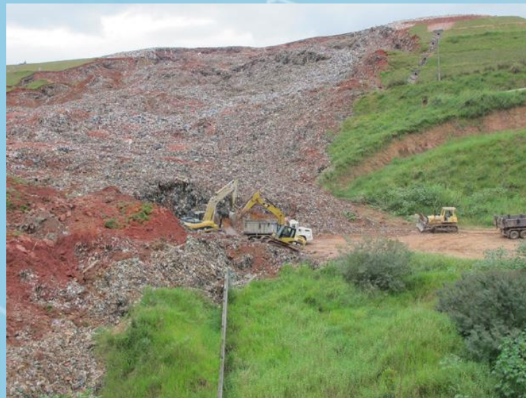
Deslizamento em lixão Local: Itaquaquecetuba-SP Créditos: Portal G1
