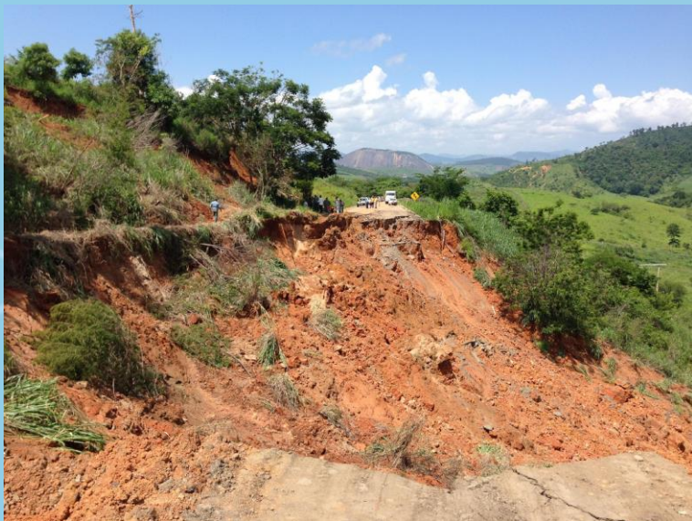
Deslizamento em aterro de rodovia Local: BR-474, Aimorés-MG Créditos: Julio Lana – CPRM/SGB
