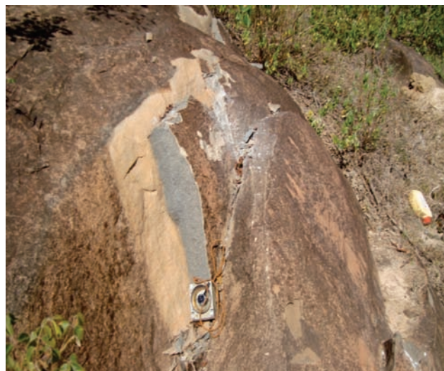
Figura 5.14 - Unidade Quartzítica da Formação Salinas: aspecto da rocha alterada. Coordenadas UTM: 797062E e 8240374N
