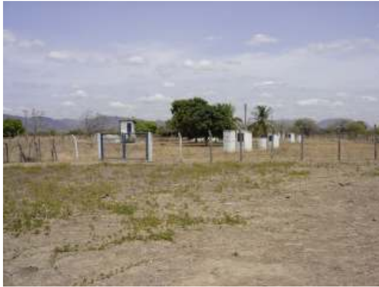
Foto 9.2 - DOMÍNIO HIDROGEOLÓGICO 1 - Bateria de poços amazonas captando água em aluviões (N34a) que abastecem a sede municipal de Umari (CE).
