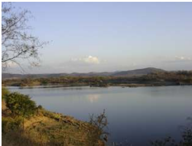
Foto 9.6 - Vista do Açude São Gonçalo, responsável pelo projeto de irrigação de mesmo nome. A barragem está localizada em área de cristalino - domínio 6 - na borda da Bacia do Rio do Peixe.
