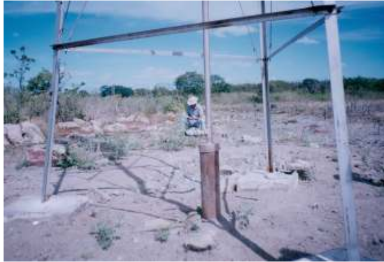
Foto 9.8 - Poço tubular equipado com catavento, localizado em área pertencente ao domínio hidrogeológico 6 - aquífero fissural.
