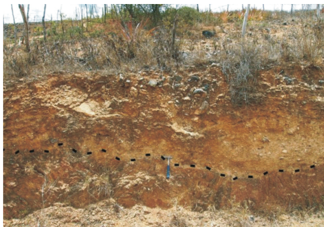
Figura 3.8 – Contato (não-conformidade) entre os filitos da Formação Palestina e os conglomerados da Formação Salvador em corte na BA-392, próximo ao Açude Adustina.
