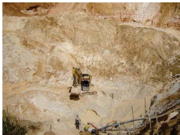
Foto 140 - Lavra em garimpo aluvionar com auxílio de retro-escavadeira. Garimpo do São Francisco - MT.
