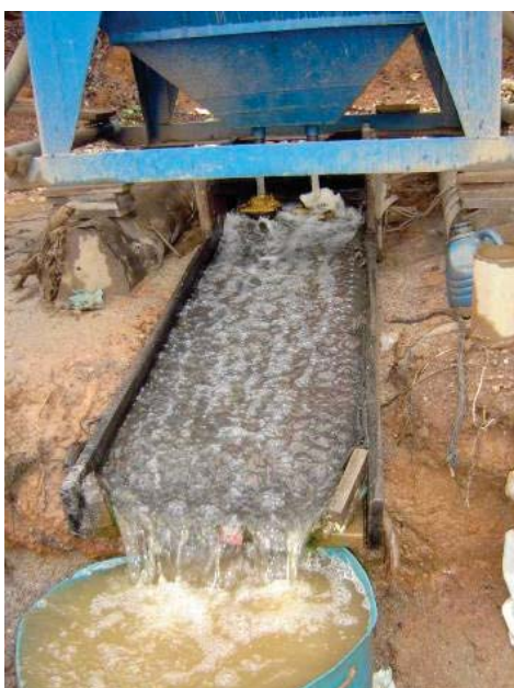
Foto 141 - Calha de madeira com estopa para a recuperação de ouro fino como subproduto da lavra de cassiterita Garimpo do
