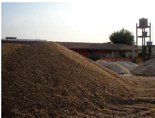
Foto 112 – Pilhas de material de construção retirado de depósito aluvionar do Rio Aripuanã em Colniza.
