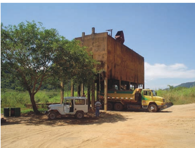
Figura 7.2 – Silo de armazenamento de areia no rio Paraíba do Sul, no município de Três Rios, RJ
