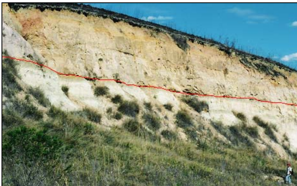
Figura 5.18: Depósitos arenosos da Formação Resende separados por uma superfície erosiva, sugerindo duas fases de sedimentação. Ponto V-17 (UTM:0595491/7507342), bairro Jardim Tiradentes, município de Volta Redonda.
