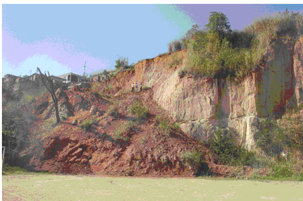
Figura 8.9 - Vista geral do deslizamento rotacional que afetou o talude a jusante da Favela do Morro do Mutuá-guaçú, em 2006
