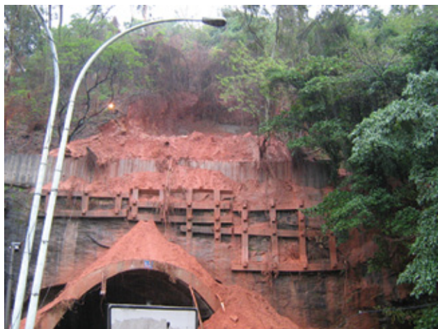
Figura 8.4 - Vista frontal do escorregamento que obstruiu a entrada do Túnel Rebouças, no centro do Rio de Janeiro, em 2007, e que deixou a cidade parada por mais de 04 dias (foto do autor)
