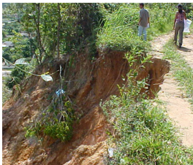
Figura 8.9 - Vista geral do deslizamento rotacional que afetou o talude a jusante da Favela do Morro do Mutuá-guaçú, em 2006
