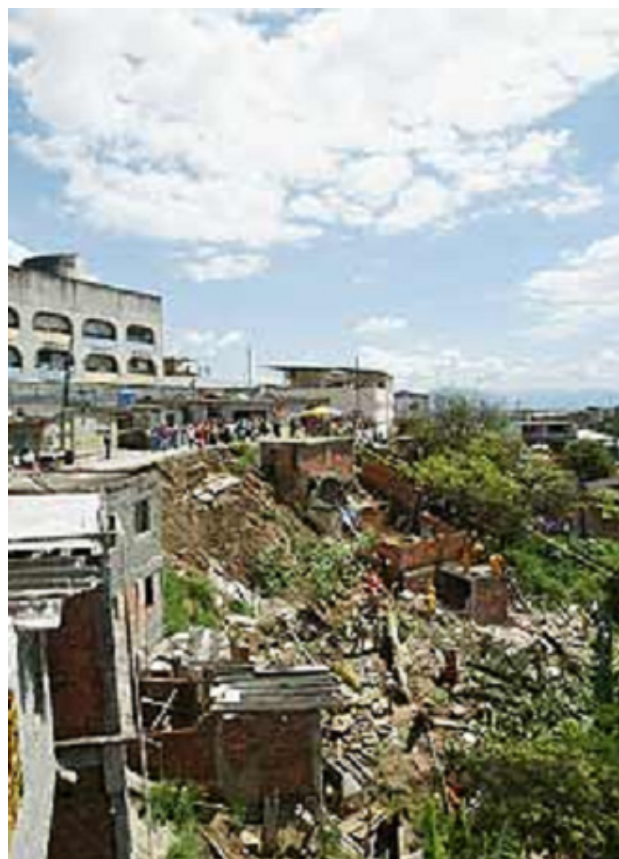
Figura 8.3 - Vista do escorregamento de solo, lixo e entulho, ocorrido em Maio de 2003, que destruiu mais de 10 casas e causou 6 mortes, na Favela do Morro da Vila Cruzeiro
