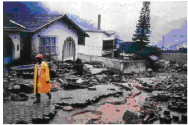
Figura 8.13 - Vista da destruição causada pelo "debris flow" do Mori, em 1988. Notar a permanência das casas, uma vez que o fluxo de massa seguiu o eixo da via
