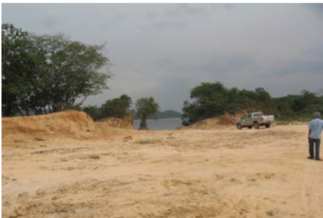
Figura 7.3 – Depósito de areia às margens do rio Tocantins, na cidade de Tucuruí.
