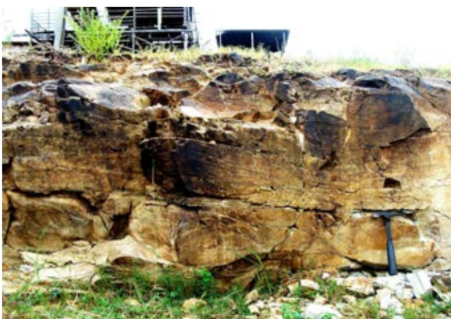
Figura 3.40 – Bancadas fluviais exibindo estratificação cruzada hummocky nos arenitos finos da Formação Tucuruí;
